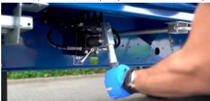
Foto 2: posizione della pompa idraulica
