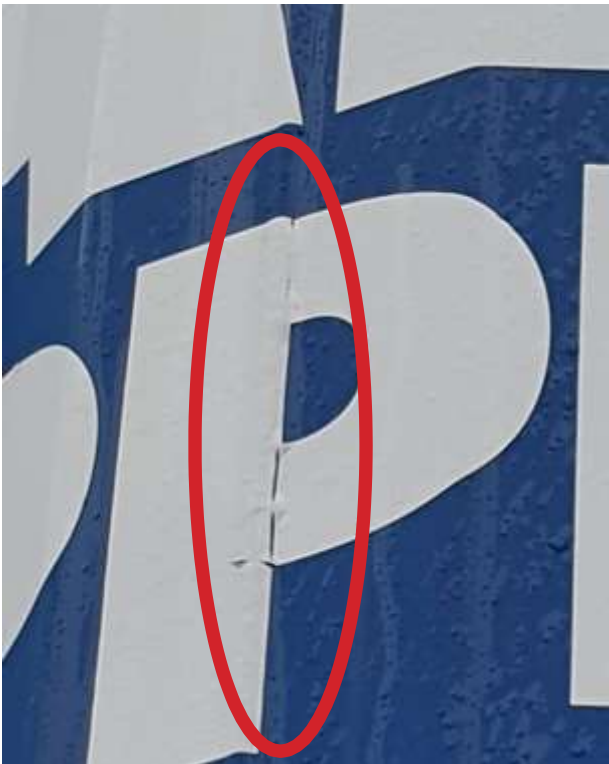
Immagine 1: adesivo che si stacca sulla linea di saldatura ad una testata
