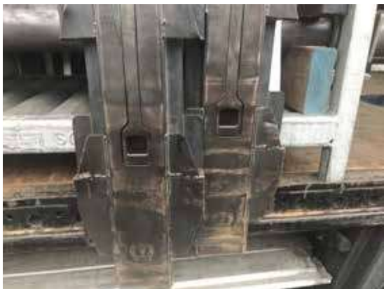
Fig. 1: Esempio di ruggine in superficie ai piantoni
